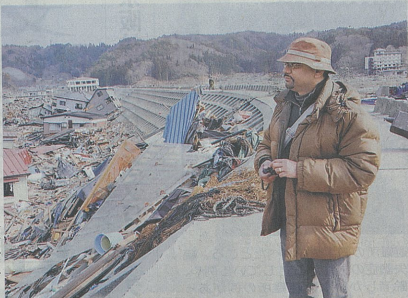
津波が乗り越えた防潮堤の上から破壊された市街地を見るシヨウウ・ラジブ准教授。2日、岩手県宮古市
