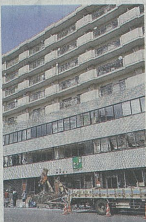
岩手県釜石市浜町の津波避難ビル。3階まで津波が達したが4階以上の避難スペースは守られた。2日
